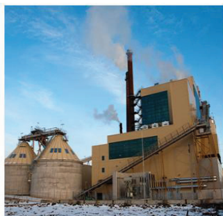
Торфяные пеллеты для топлива и теплоэлектростанция на торфе (характеристики теплоэлектростанции - 50 Мвт тепла, 25 Мвт электричества)
