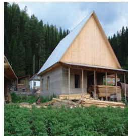
для Сруб дома из торфяных плит
